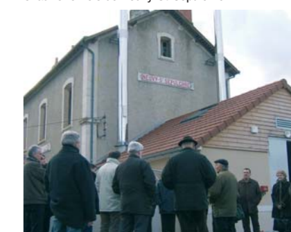
Chaufferie Bois de Neuvy-St-Sepulchre
