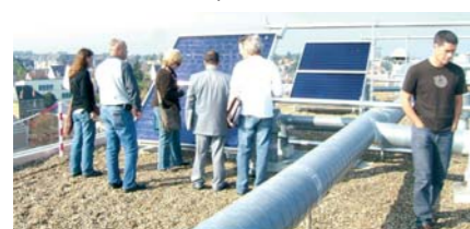
100 m 2 de capteurs solaires thermiques en terrasse
