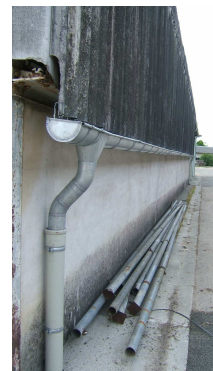
Adaptation des gouttières à la récupération d'eau de pluie des toitures
