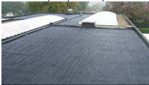
180 m 2 de moquette solaire en toiture terrasse
