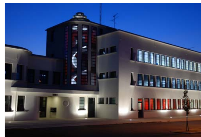
Pôle Image Arts Formations (PIAF) à Issoudun (Ancienne friche Indreco)
