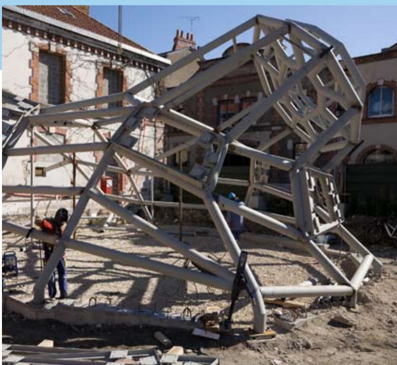
Chantier du FRAC Centre Photo—FRAC Centre (en haut) Photos—François Lauginie
