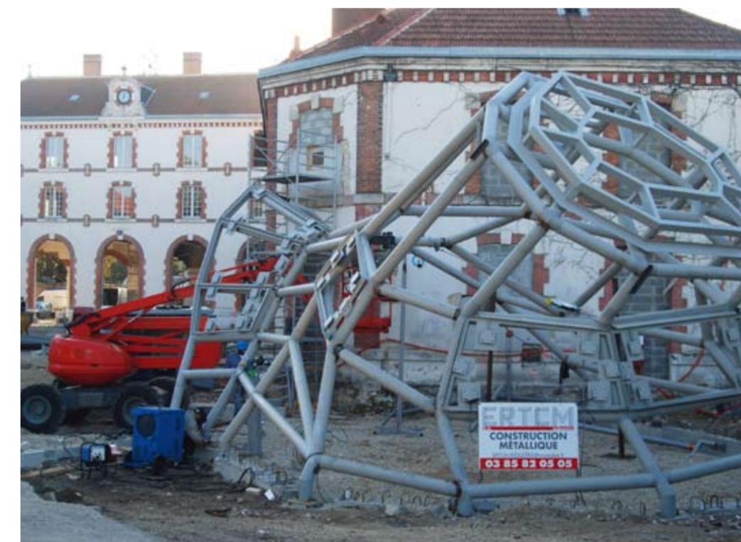
Chantier du FRAC Centre Photo-FRAC Centre
